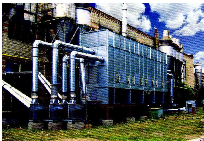
Реконструкция системы аспирации фабрики Мелитополь мебель
